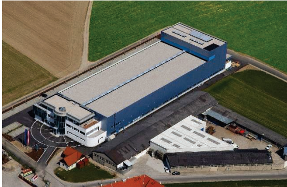
© weba Werkzeugbau Betriebs GmbH
